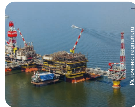
МЛСП им. Филановского. Пожарные шкафы, система дозирования пенообразователя. Заказчик: ЛУКОЙЛ
