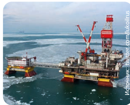
Блок-кондуктор месторождения им. Ю. Корчагина. Распределенная система дозирования пенообразователя, пожарные шкафы. Заказчик: ЛУКОЙЛ
