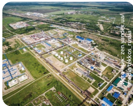
Афипский НПЗ. Комплексы пожарного оборудования, системы хранения и дозирования. Заказчик: ОПТИМА ЭНЕРГОСТРОЙ
